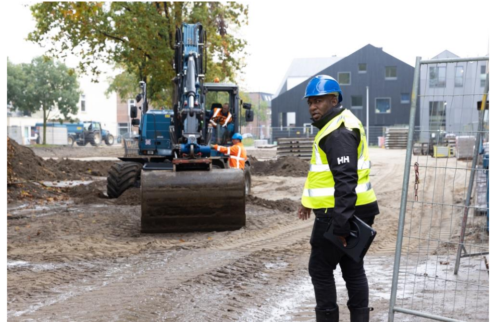
Bouwplaats 2e Daalsedijk
