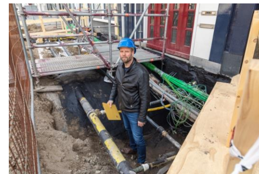
Bouwplaatsinspectie in stadscentrum
